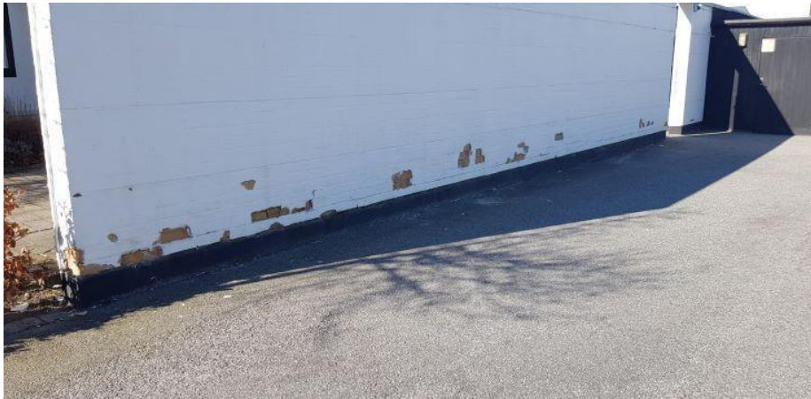
Figur 5: Exempel på markfukt som orsakar sprucket tegel
